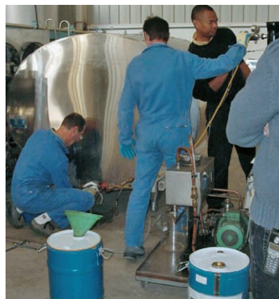
Extraction du produit de nettoyage, chasse à l'azote et contrôle du résiduel.
